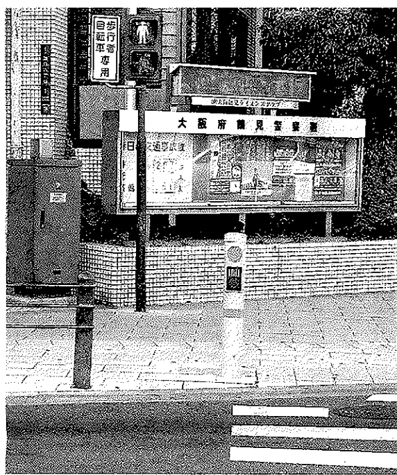
鶴見警察署前の交差点で検証中の「LED付き音響信号装置」(埋め込み型)
