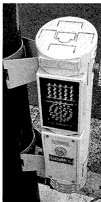
上の長方形が「赤」、下の円形が「青」。その下に延長押しボタン(抱え込み型)
