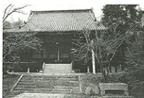
②金山寺本堂の火災で 消火作業などに集まっ た消防団員ら ＝24日午後8時52分、 岡山市北区 ③火災のあった金山寺 本堂 (岡山県提供)
