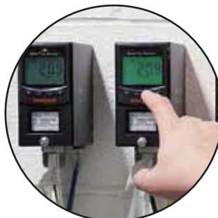
Midasガス検知器には明るいLEDライトが搭載されています。これにより、ガスの読み取りやアラームレベルに対して即時に注意喚起できます。小型で取り扱いが容易な金属製シャーシを備えたMidasガス検知器は設置が簡単です。これはスペースが非常に限られている、混雑していて複雑な処理環境では特に重要です。
