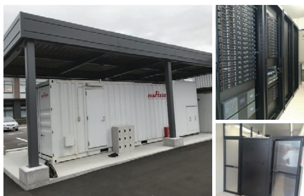
※写真は(株)村田製作所 長岡事業所に設置の直流給電サーバ 評価試験設備です。
