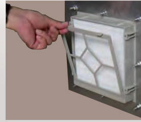
フィルターのメンテナンスは裏面側から行います
